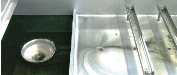
Magnetfiltration im Zulauf des Koaleszenz-Ölabscheiders
